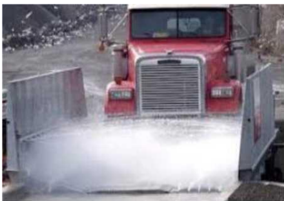
Hình 3.1. Minh họa hình ảnh trạm rửa xe tại công trường
