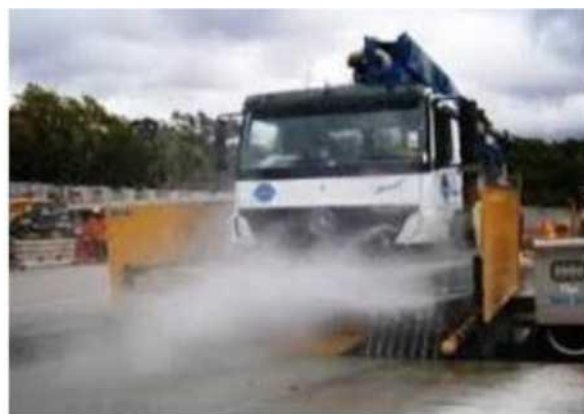
Hình 3.1. Minh họa hình ảnh trạm rửa xe tại công trường
