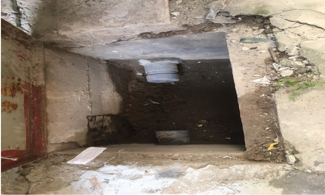
Hình 3.5. Vị trí đồng hồ tại đơn nguyên 1 sau khi được tháo và bịt đường ống thoát nước
