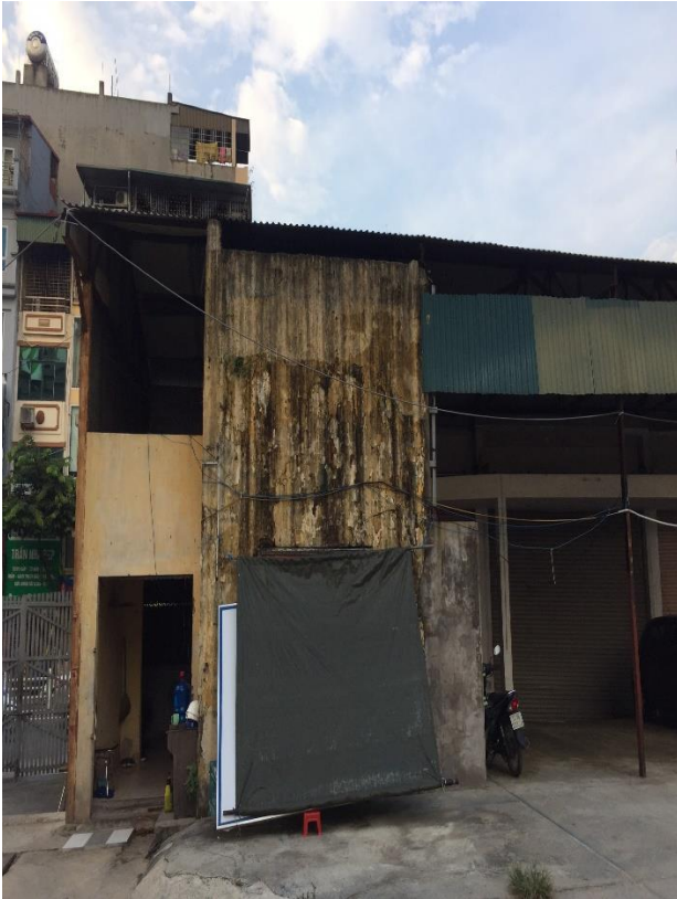
Công trình còn tồn tại trong dự án
