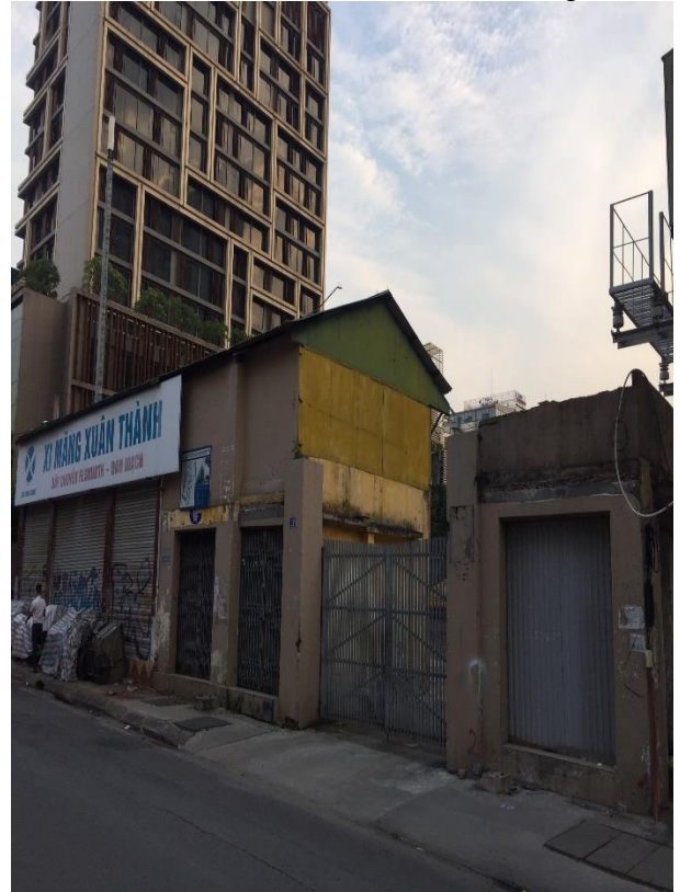
Công trình giáp mặt đường Cát Linh
